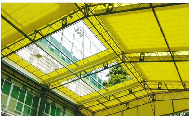
施工例：工場荷捌き場
