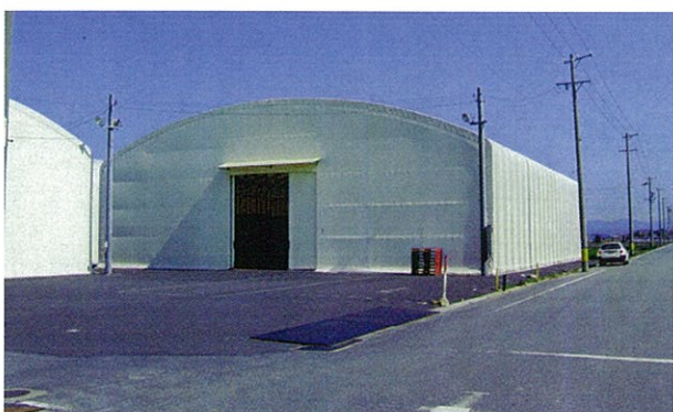
施工例：テント倉庫
