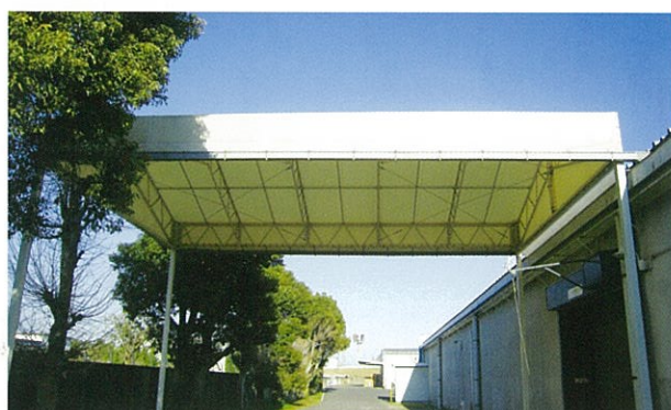
施工例：工場荷捌き場
